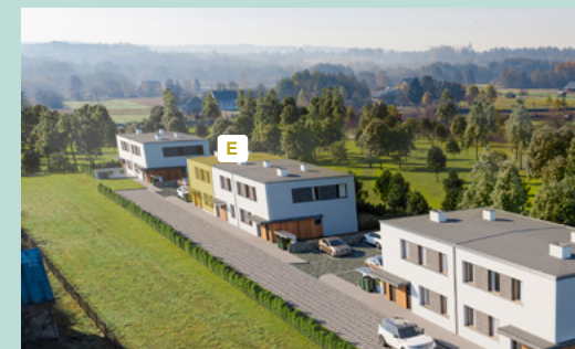
Widok osiedla z lotu ptaka
