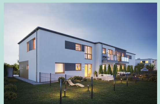
Widok budynku od strony ogródka
