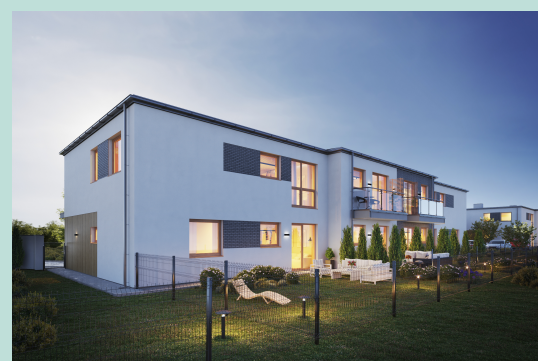
Widok budynku od strony ogródka
