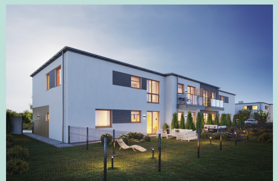
Widok budynku od strony ogródka
