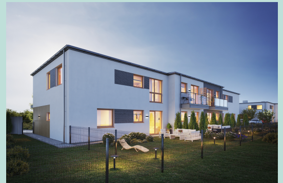
Widok budynku od strony ogródka
